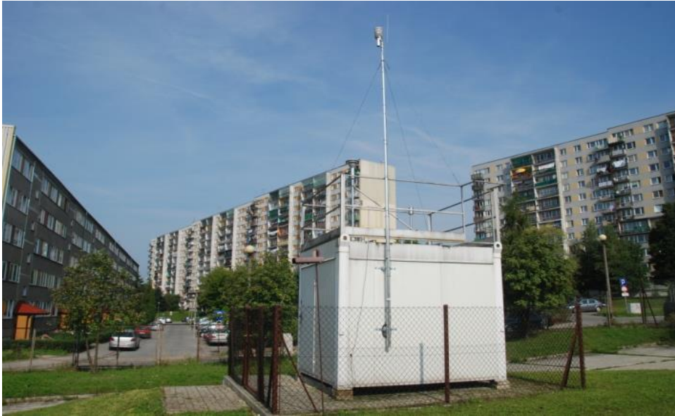
Fot.1. Stacja pomiarów zanieczyszczeń powietrza w Tarnobrzegu, ul. Bitwy pod Studziankami.
