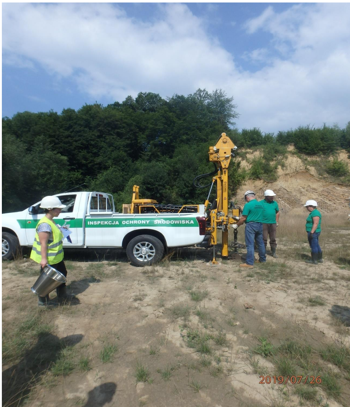
Pobieranie prób gruntu w miejscu składowania odpadów.
